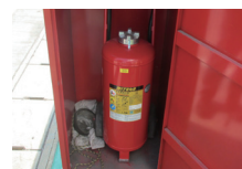
(6) 防火設備状況
