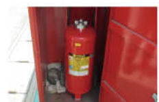
(6) 防火設備状況
