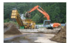
(5) 設備稼働状況(破碎)
