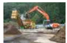
(5) 設備稼働状況(破碎)
