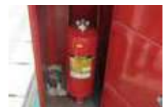
(6) 防火設備状況
