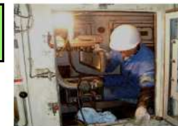
設備の清掃保全
