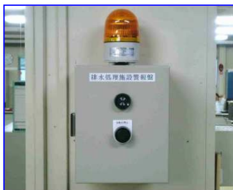
排水異常警報装置の設置 (異常排水流出情報による)
