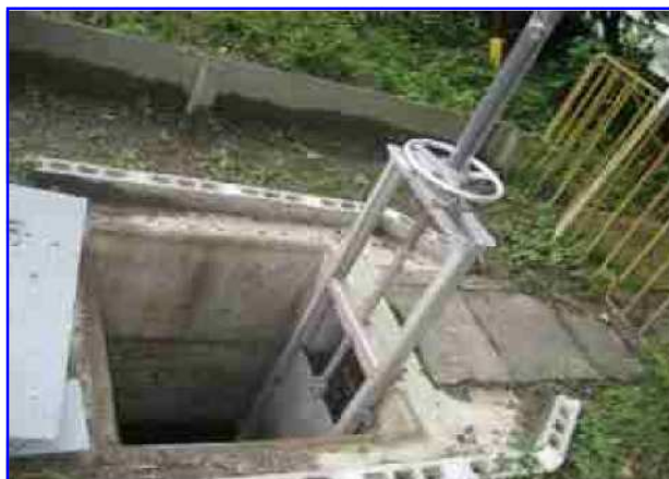
対策1 緊急遮断弁の設置 (水質事故情報による)
