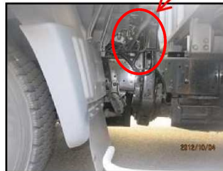
作動油系ホースの破れ
