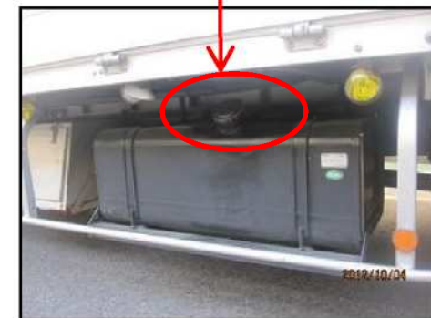
燃料タンク過給油、 サブタンクとの連結部
