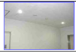
2階エレベーター前... LED電球型ダウンライト2個
