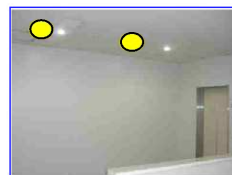
3階エレベーター前... LED電球型ダウンライト2灯
