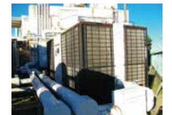
冷凍機室外機
